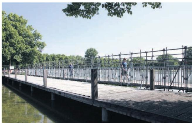
■ Die Holzbohlen sind schon deutlich verzogen, obwohl die Brücke nie in Betrieb war. Die Baufirma hatte minderwertiges Holz verbaut, deshalb muss die Brücke vor einem erneuten Neubau abgerissen werden. Foto: Figge
